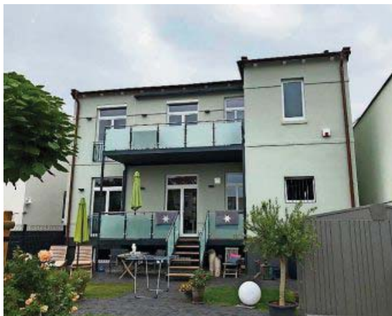
Vorgesetzte Balkone können die Optik eines Gebäudes völlig verändern. Foto Ulrich
